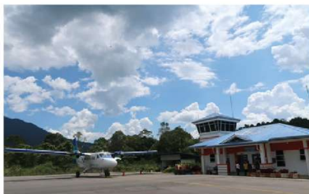
Lapangan terbang perlepasan dan pendaratan pendek (STOLport) Long Lellang di tengah-tengah tumbuh-tumbuhan hijau yang subur dan tanah tinggi yang berceranggah
